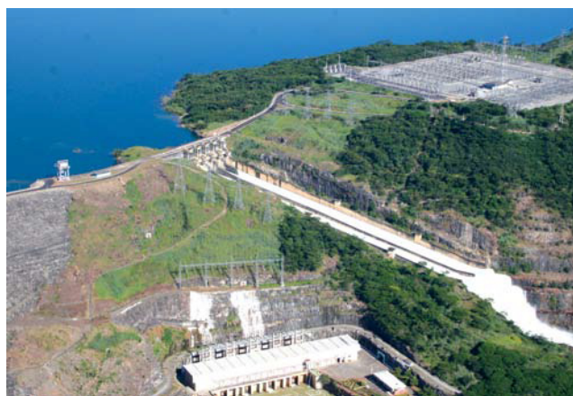
Figura 1 – Barramento da UHE Emborcação
