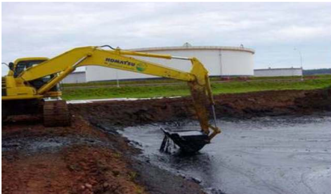
Figura 1 – Remoção da borra oleosa para posterior coprocessamento.
