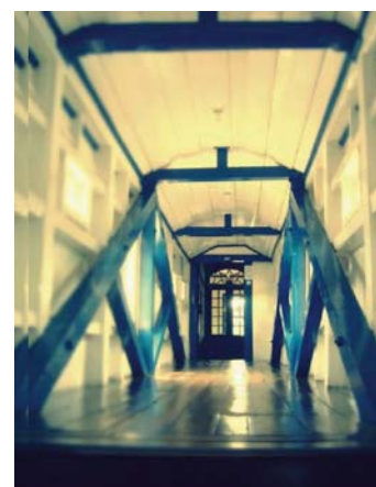
Figura 04: Vista interna do passadiço da Casa da Glória, Instituto Casa da Glória, 2015. Foto: Isabella Brandão Lara
